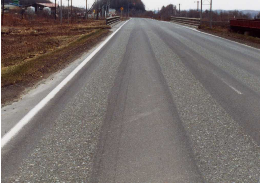
スパイクタイヤによる摩耗によって生じたわだち掘れ(過年度)
