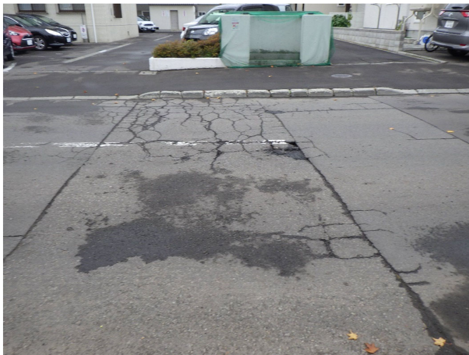
施工継ぎ目のひび割れ(横方向)の状況
